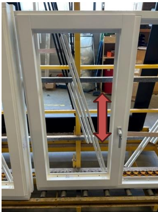
11. Raam verstellen in de hoogte, sluitzijde
