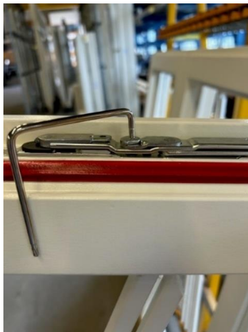
6. Met torx-bit raam verstellen in de breedte
