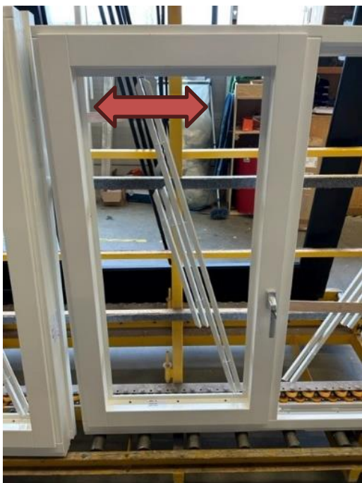
5. Raam verstellen in de breedte, bovenzijde
